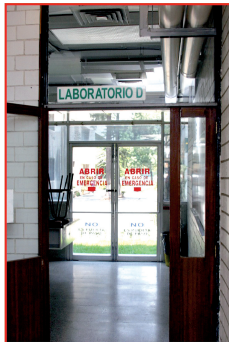
Imagen 17: Puertas de emergencia.
